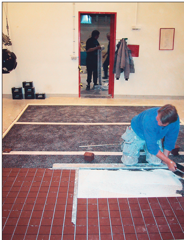
Utspackling av fix för montage av keramikplattor på stegljudsdämpande matta vid SP i Borås.
